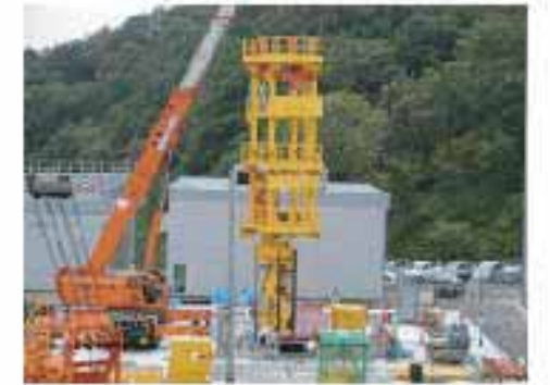
換気立坑内に入れる前のスカフォード
